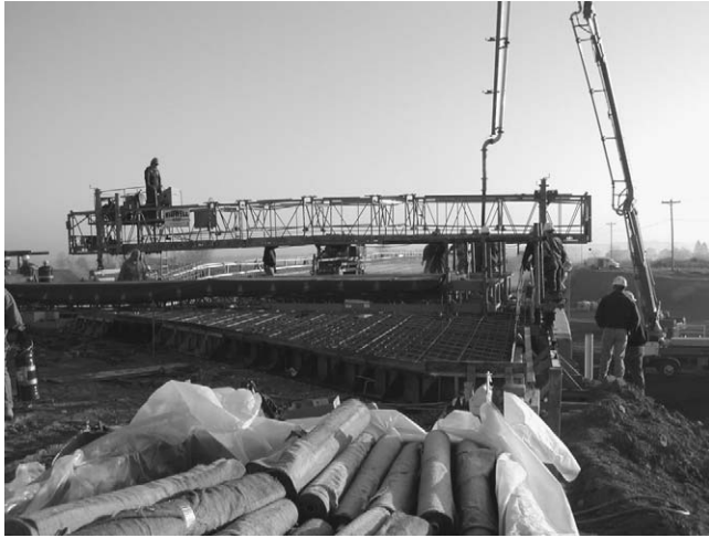
Fig. 3. Deck pour orientation—perpendicular to the roadway centerline.
